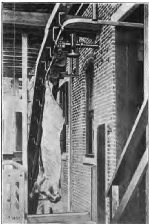
Abb. 150. Hängebahn der Link Belt Engineering Co. in Philadelphia zum Transport von Fleisch aus den Schlachthäusern zu den unteren Gefrierabteilungen.
