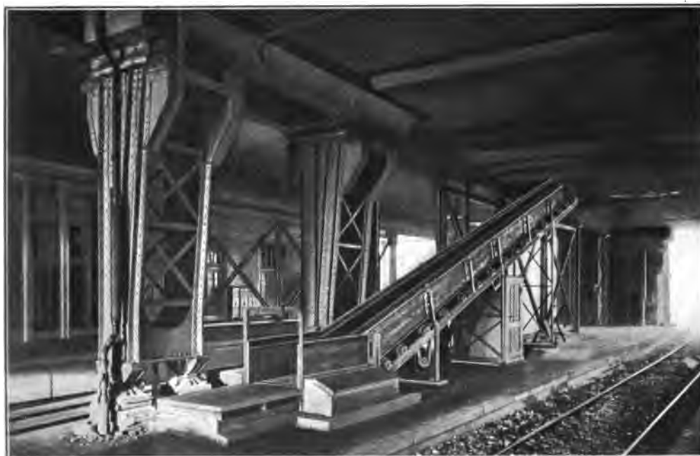
Abb. 477. Gurtförderer für Gepäck auf dem Hamburger Hauptbahnhof (Unruh & Liebig in Leipzig). Vgl. Abb. 501.
