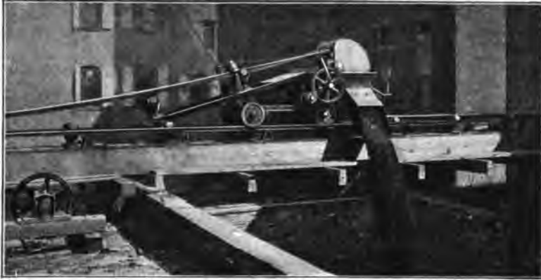
Abb. 443. Kohlenförder- und -lageranlage der National Lead Co. in Brooklyn.
