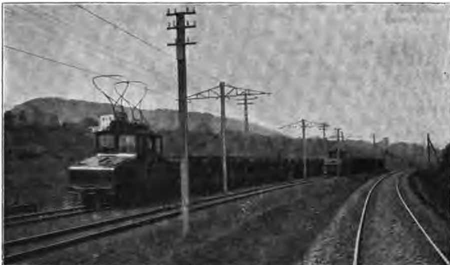
Abb. 90. 225 pferdige Siemens-Schuckert-Lokomotive (Rombacher Hütte) mit Selbstentladerzug.
