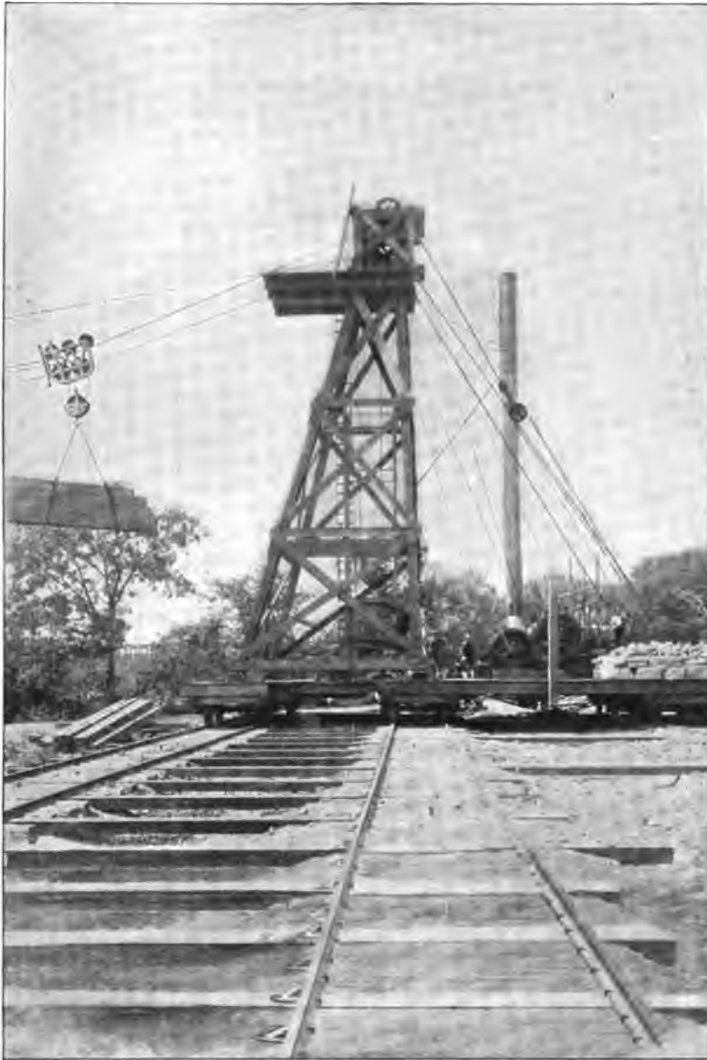
Abb. 395. Hauptgerüst mit Maschinen (zu Abb. 393).
