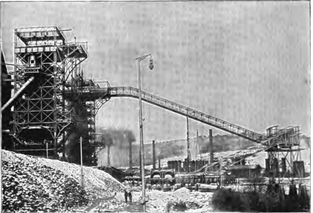
Abb. 292. Gichtseilbahn von A. Bleichert & Co. in Leipzig für die Fentcher Hütten-A.-G. in Kneuttingen (Lothringen).
