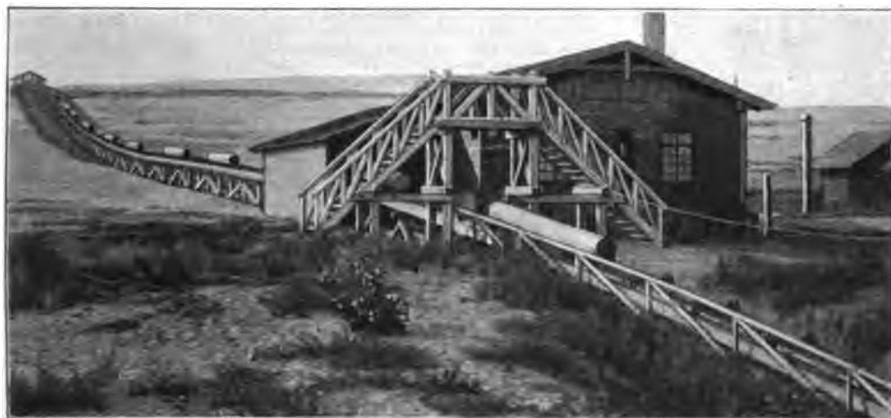
Abb. 48. Kettenaufzug für Flossholz (Russland) von A. Koppel, A.-G., in Berlin.
