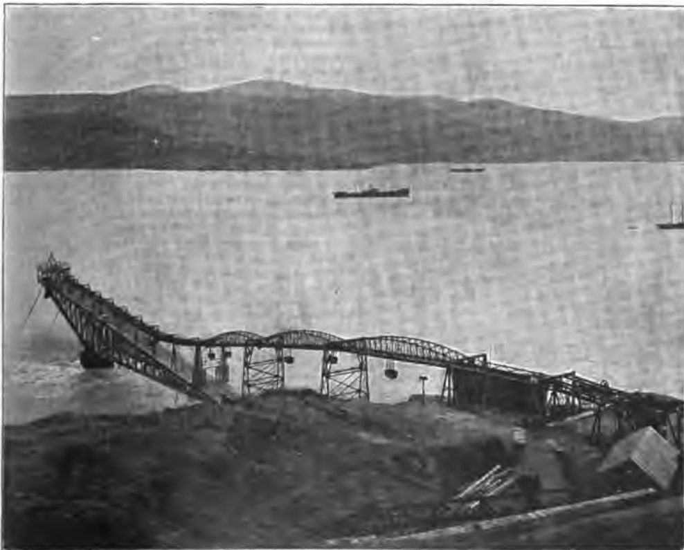
Abb. 152. Verladebrücke der Vivero Iron Co., London, in Spanien von A. Bleichert & Co. in Leipzig.
