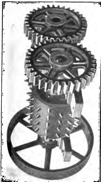
Abb. 490. 20pferdiger Brecher mit Stahlgusszähnen (offen).
