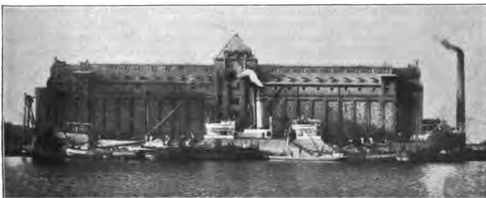
Abb. 703. Silospeicher für die Maatschappij tot Exploitatie van Graansilos en Pakhuizen in Amsterdam, gebaut von Unruh & Liebig in Leipzig.
