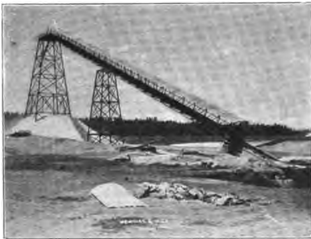
Abb. 471. Gurtförderer mit Türmen für Haldenbeschickung.
