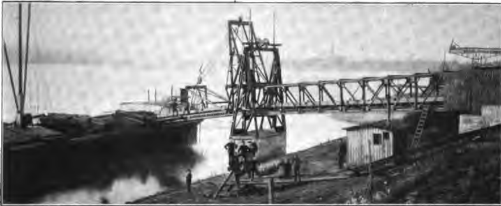
Abb. 500. Rollenförderer für Holzverladung (gebaut von J. Pohlig, A.-G., in Cöln).
