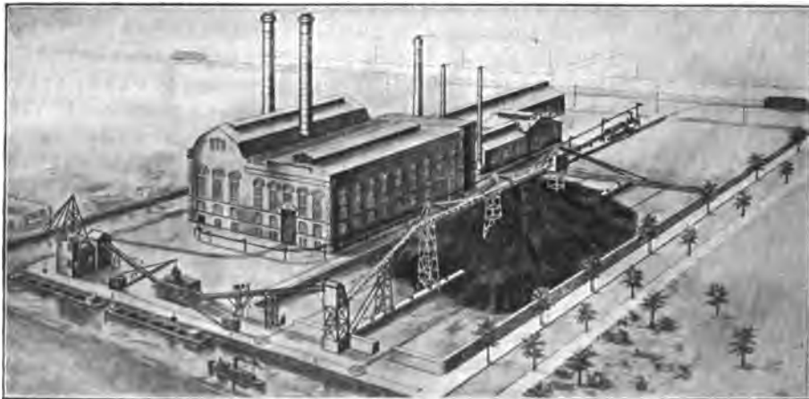
Abb. 802. Kohlenförder- und -lageranlage der American Tube & Stamping Co. in Bridgeport (Robins Co.).
