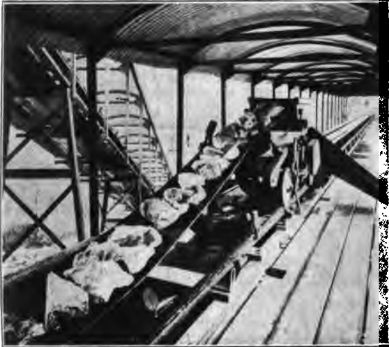
Abb. 482. Selbsttätiger Ablader zum Verteilen von Kalksteinen in Oefen (Muth-Schmidt in Berlin).
