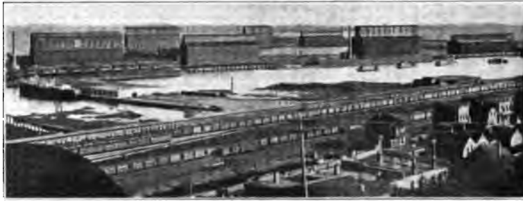
Abb. 682. Speichergruppe der Consolidated Elevator Co. in Duluth.
