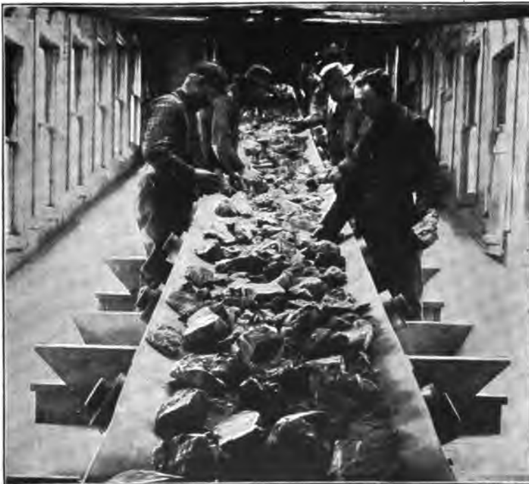
Abb. 484. Lesegurt in einer Erzmine.
