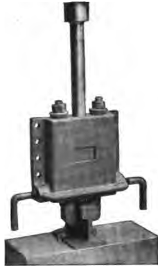
Abb. 371. Schienenklammer.
