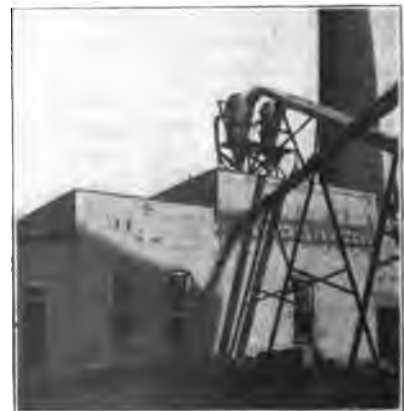
Abb. 675. Staubleitungen nach dem Kesselhaus.
