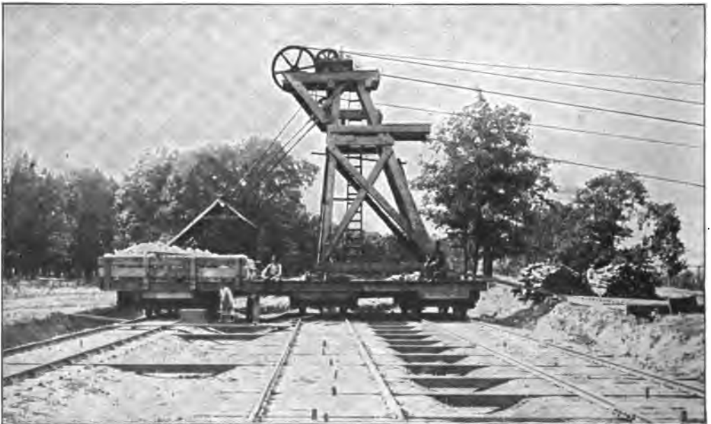
Abb. 394. Hintergerüst (zu Abb. 398).
