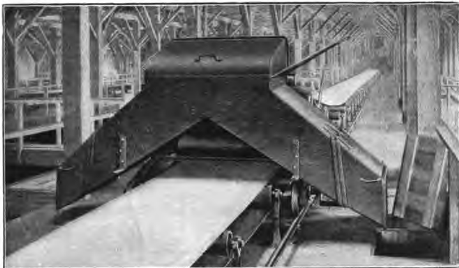
Abb. 438. Flacher Gurtförderer mit fahrbarem Abwerfer.
