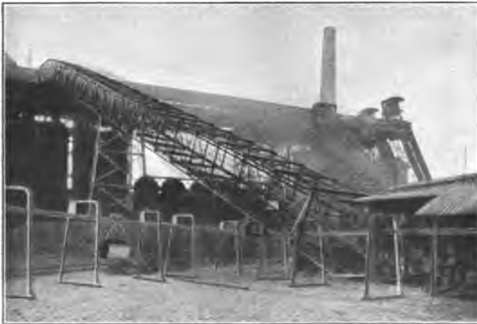
Abb. 294. Hängebahn mit Seiltrieb für Hochofenbegichtung in Deutsch Ach, Rothe Erde bei Aachen (J. Pohlig, A.-G., in Cöln).
