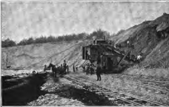
Abb. 588. Trockenhoebagger der Lübecker Maschinenbaugesellschaft.
