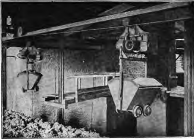
Abb. 139. Elektrohängebahn für Zementklinker in Göschwitz von A. Bleichert & Co. in Leipzig.
