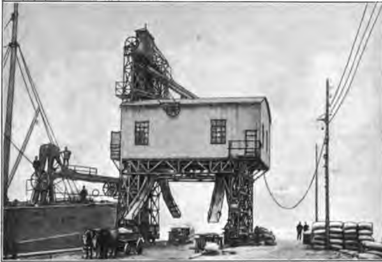
Abb. 609. Schiffselevator mit Sackrutsche in Christiania von Amme, Giesecke & Konegen, A.-G., in Braunschweig.
