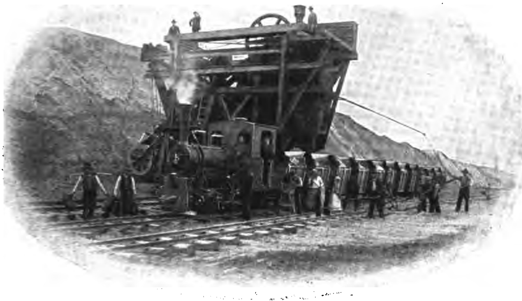
Abb. 72. 50pferdige Borsig-Lokomotive für Trockenbaggerbetrieb (785 mm Spur, 9,5 t Dienstgewicht).
