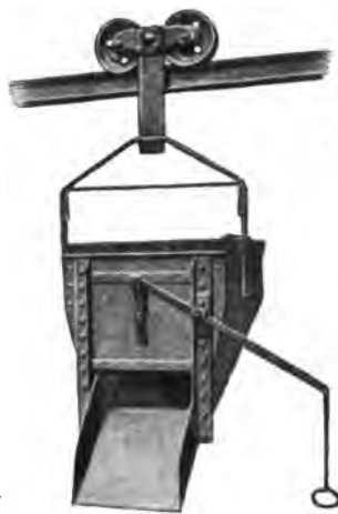
Abb. 199. Selbstentlader (J. Pohlj, A.-G., in Cöln).
