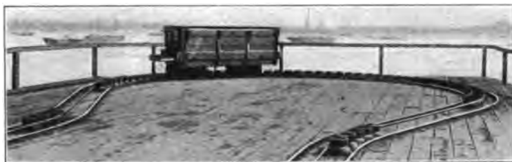
Abb. 32. Kabelbahn von Hunt-Pohlig.
