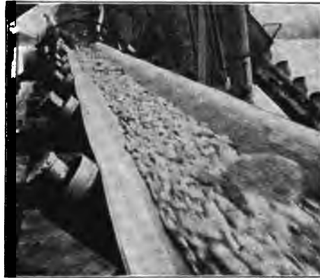
Abb. 483. Beförderung des am Eisernen Tor aus der Donau gebaggerten Materials (1200 t/st).
