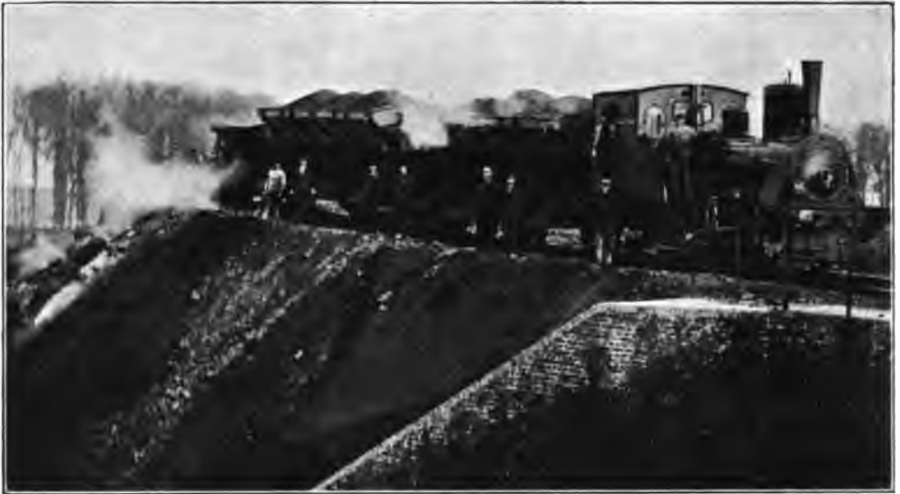
Abb. 102. Anschüttung eines Eisenbahndammes mittels Talbot-Selbstentlader.
