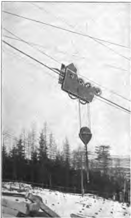
Abb. 400 a. Laufwagen zum Kabelhochbahnkran (vgl. Abb. 380—383).
