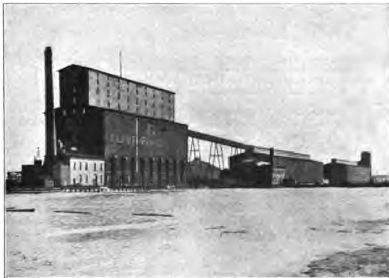
Abb. 681. Speicher mit zwei Annexbauten, Globe-Elevatorsystem, West-Superior, Wisc.
