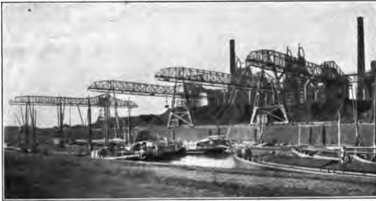
Abb. 372. Fahrbare Huntsche Verladebrücken für Erzverladung (mit Kübel oder mit Greifer arbeitend), ausgeführt für die Firma Friedr. Krupp, A.-G., in Rheinhausen von J. Pohlig, A.-G., in Cöln.
