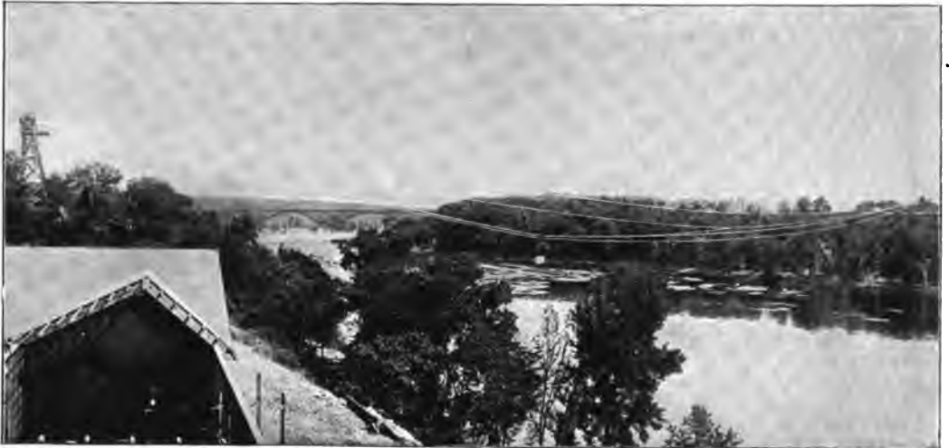
Abb. 393. Trenton-Kabelhochbahnkran in St. Paul für 350 m und 5 t.
