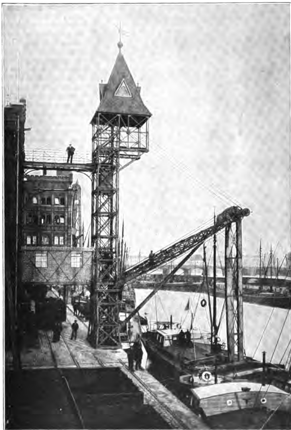
Abb. 716. Schiffselevator des Getreidesilos in Frankfurt a. M.
