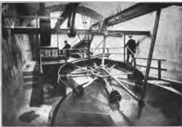
Abb. 843. Versuchskläranlage in Dresden.
