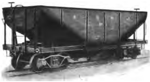
Abb. 110. Bodenselbstentlader der Wellman-Seaver-Morgan Co. in Cleveland.
