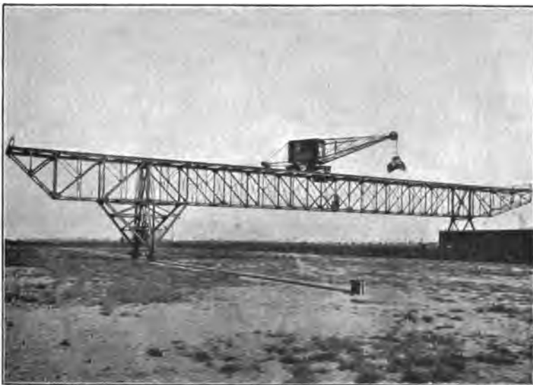
Abb. 350. Lagerplatzkran von Mohr & Federhaff in Mannheim.
