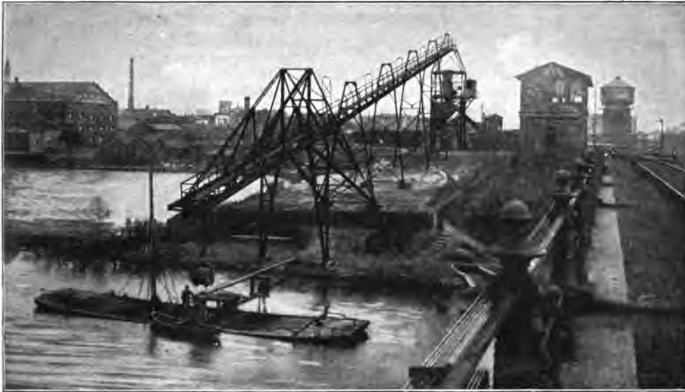
Abb. 295. Schiffsentladeanlage in Hamm (A. Bleichert & Co. in Leipzig).
