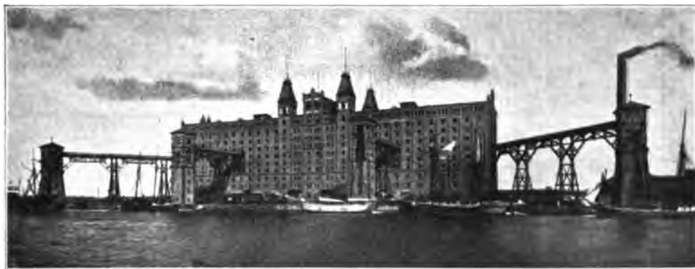
Abb. 706. Getreidespeicher in Königsberg, gebaut von C. G. W. Kapler, A.-G., in Berlin.
