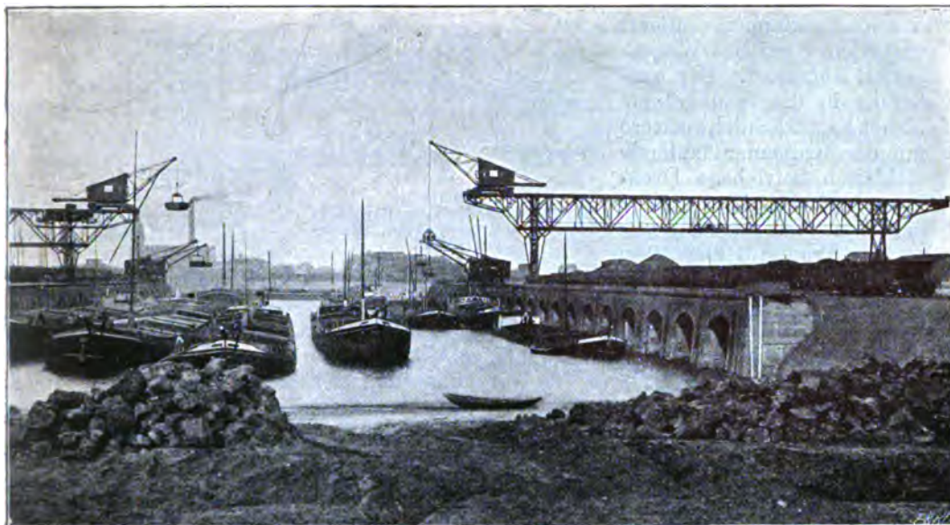
Abb. 376. Umschlagseinrichtung für Kohle und Erz in Walsum (von J. Jäger in Duisburg).
