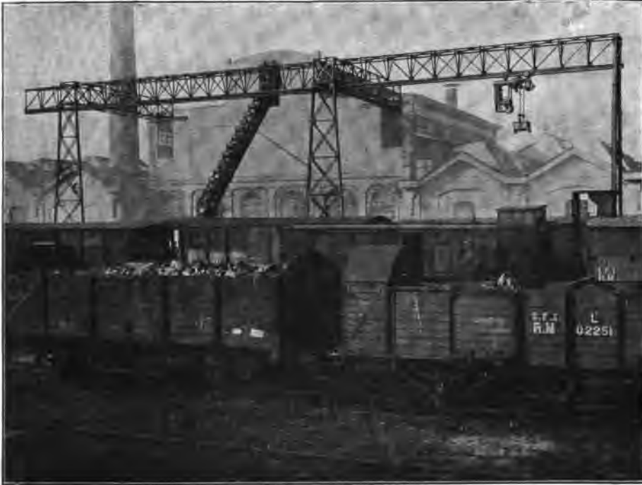
Abb. 137. Elektrohängebahn in Pavia, gebaut von A. Bleichert & Co. in Leipzig.
