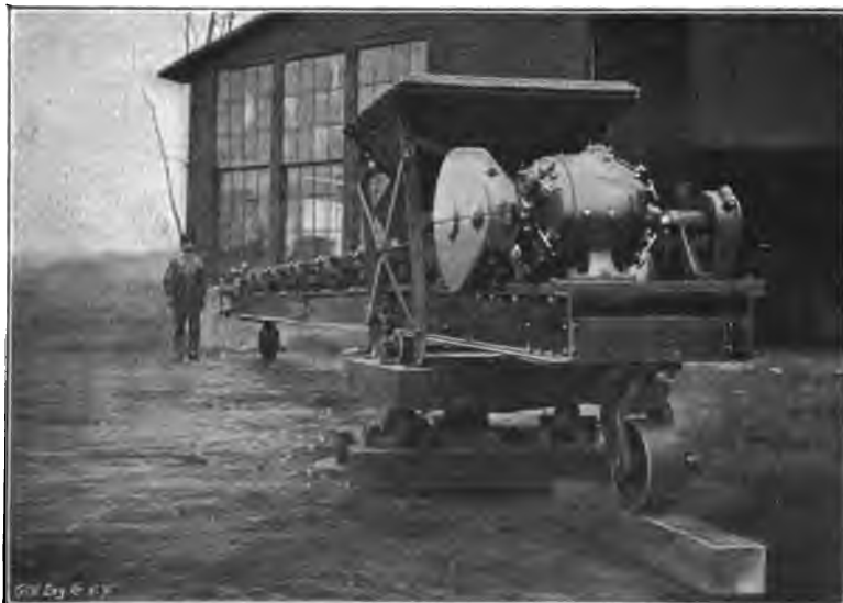
Abb. 469. Fahrbarer Gerüstgurt der Moctezuma Copper Co. in Mexiko.
