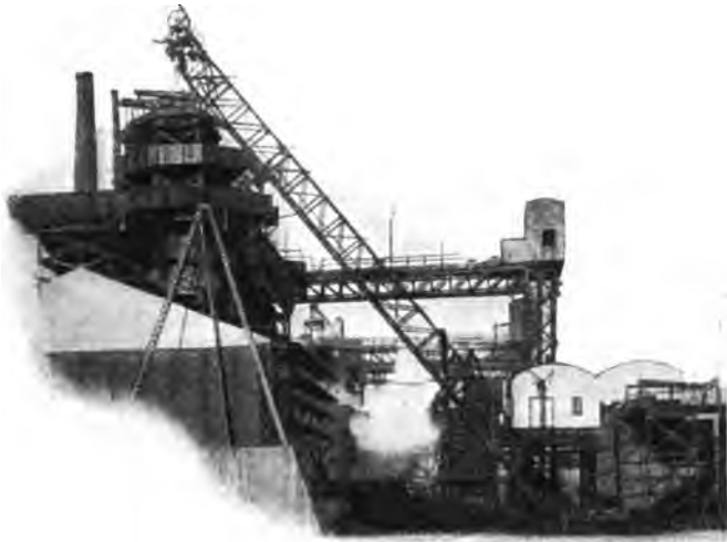
Abb. 275. Amerikanischer Schrägaufzug, ausgeführt von J. Pohlig, A.-G., in Cöln für das Eisen- und Stahlwerk Hoesch in Dortmund.
