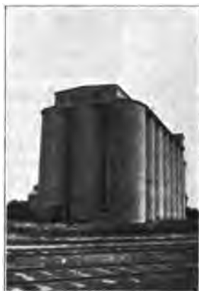
Abb. 680. Speicher aus Eisenbeton (Concret), Minneapolis, Minn.
