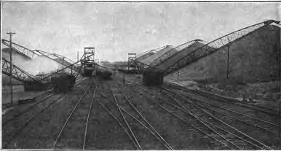
Abb. 787. 480000 t-Lager nach Dodge bei Abrams (Philadelphia und Reading Coal & Iron Co.).
